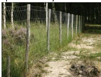
Clôture bois et grillage perméable petite et moyenne faune
